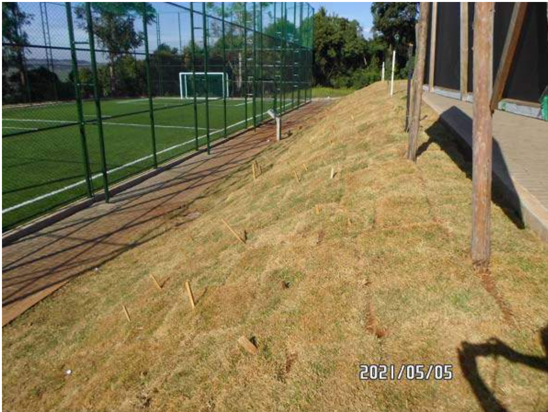
FOTO 01 – GRAMA ESMERALDA PLANTADA NO TALUDE DO CAMPO I
